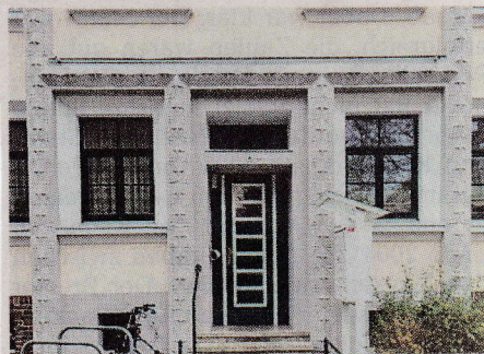
Den Preis erhält diese denkmalgeschützte Fassade an der Berdingstraße 1-7 in Linden-Nord.
